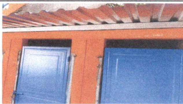
Foto 2: Sustitucion de estructura de soporte de madera por metal de servicios sanitarios de niños y niñas del establecimiento
