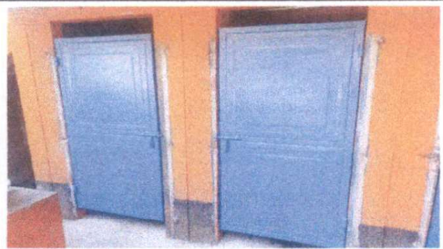
Foto 3: Mantenimiento a estructura (Ilijado, cambio de tubo , cepillado, sujeciones, aplicación de pintura) de 2 puertas de servicios sanitarios de la escuela
