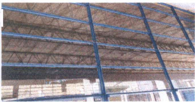
Foto 5: Sustitucion de estructura de metal de ventana de la cocina
