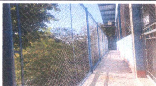
Foto 6: Sustrución de muro perimetral con tubo HG y malla galvanizada de la cancha del establecimiento
