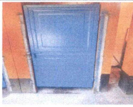
Foto 4: Sustitucion de 1 puerta servicio Sanitario de niños del centro educativo
