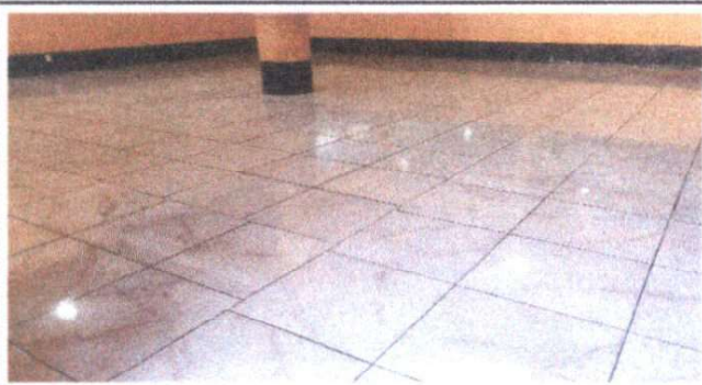
Foto 1: Sustrución de piso cerámico 2 aulas, dirección, bodega y cocina
