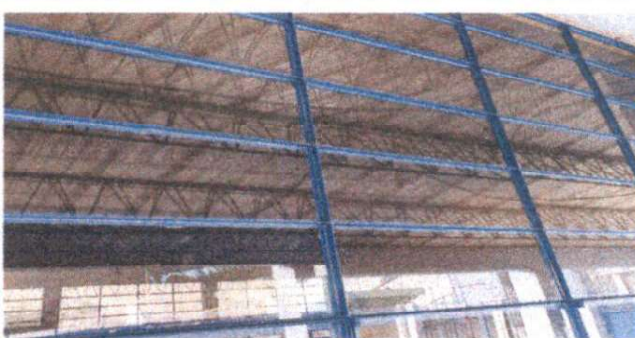
Foto 6: Sustitucion de vidrios de ventanal de cocina
