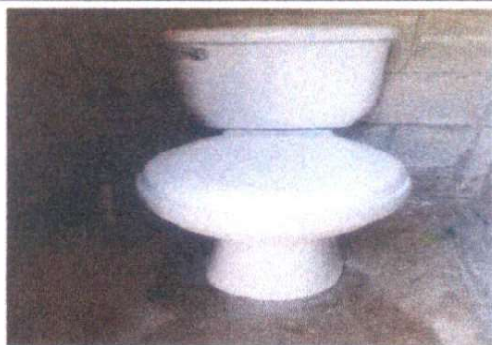
Foto 3: Sustrución de inodoro, servicios sanitario de niños
